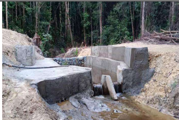
Penyelenggaraan gabion empangan air SFM Sugut
